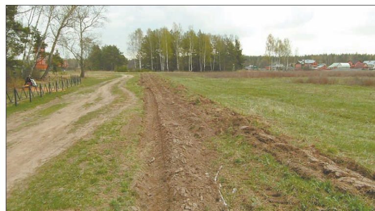
Новое ограждение кладбища и полоса противопожарного опашивания деревни Юркино.
