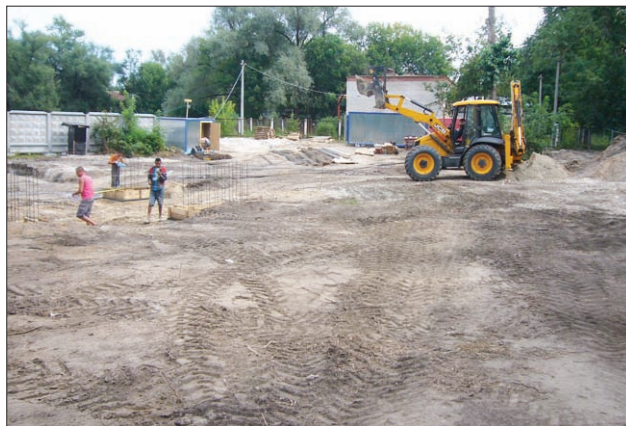
Подготовительный этап строительства выполнен.
