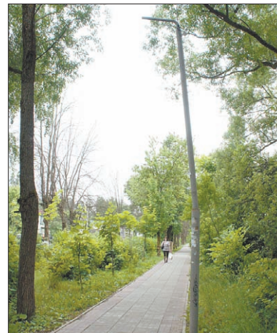
Пострадавшая опора освещения.
