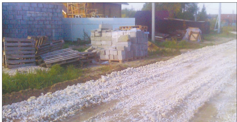
Строительство дороги вдоль улицы Новой.
